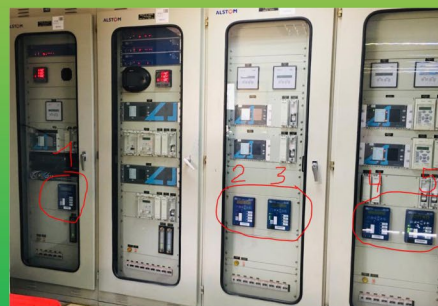
Instalación de medidores de Q.P. en la Subestación San José.
