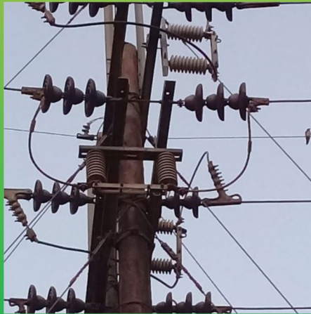
Estructura N° 103 (RH-280) Vereda las Pavas, instalación de cuchillas monopolares
