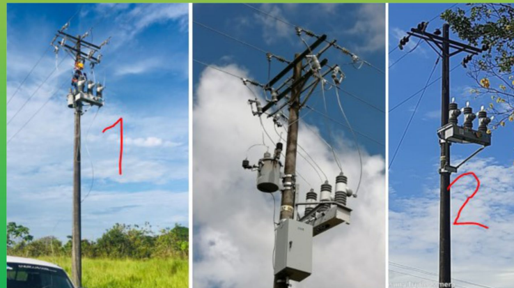
Montaje de dos (2) reconectores, Barrancón y Terpel Cto 3.
