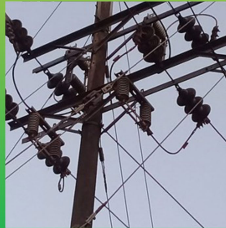
Estructura N° 161 (RH-231) Vereda Las Damas km 16-17, instalación de cuchillas
