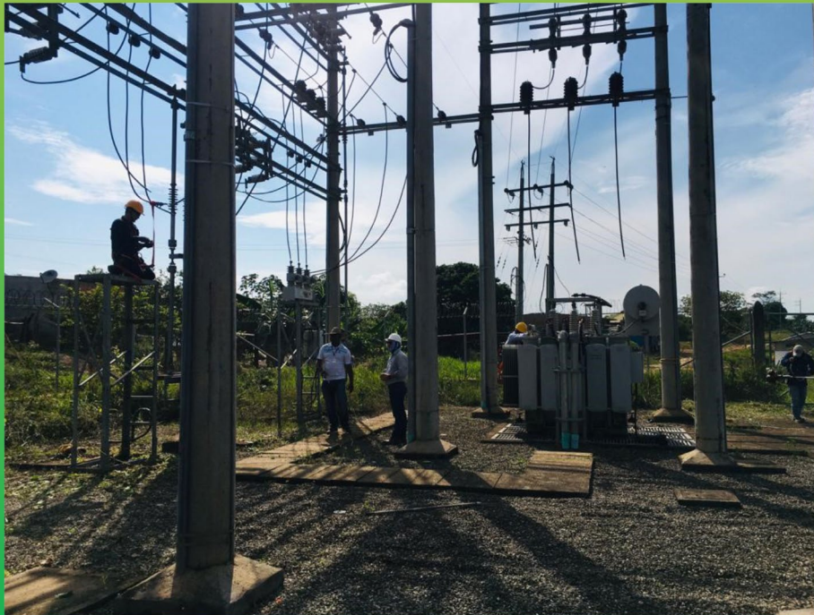
Ilustración 2 Registro fotográfico del mantenimiento y entrada en operación de la subestación Capricho
