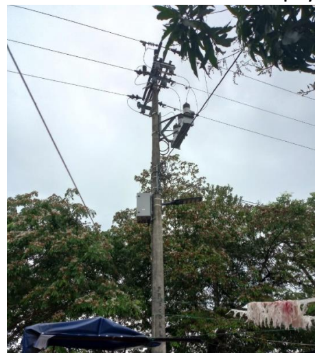
Ilustración 2. Instalación del reconductor sector Terpel y Malecón.
