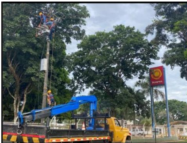
Ilustración 2. Instalación del reconductor sector Terpel y Malecón.
