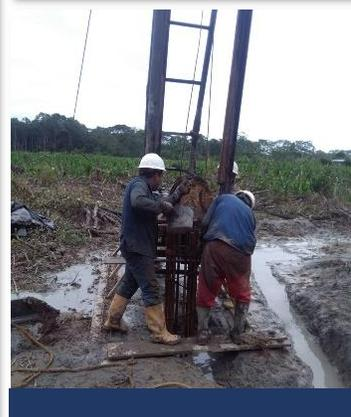
Proceso de construcción de zapatas, vigas y pedestales en la torre (T1) en el sector de la vereda de Puerto Colombia departamento del Meta.
