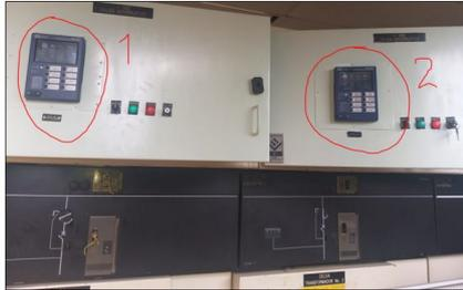
Ilustración 1. 2 relés instalados y operando en las celdas de 34.5kV Retorno.
