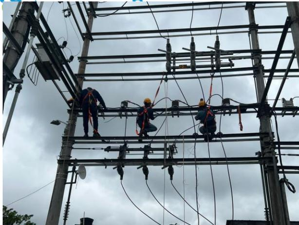
En el año 2023 se presentó la novedad de falla que quemó algunos equipos de macro medida en las cabeceras de las subestaciones de calamar y capricho, en el caso de la subestación Calamar y Capricho se reemplazó los instrumentos de medida tanto de corriente como de tensión del barraje de entrada de 34.5 kV, los equipos reemplazados se describen a continuación:
